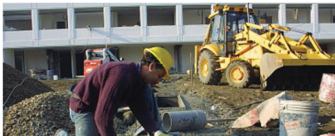
Un cantiere aperto con l'utilizzo dei fondi europei del Fesr
